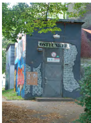
Jugendzentrum Ostbunker Oststraße
