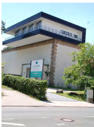
Hochbunker Buersche Straße
