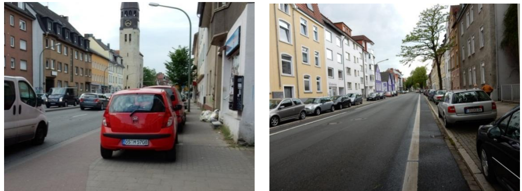
Abb. 34 Aneinanderreihung von Mindestmaßnahmen (Bsp. Iburger Straße) und fehlende Sicherheitstrennstreifen zu Längsparkständen (Bsp. Hannoversche Straße)
