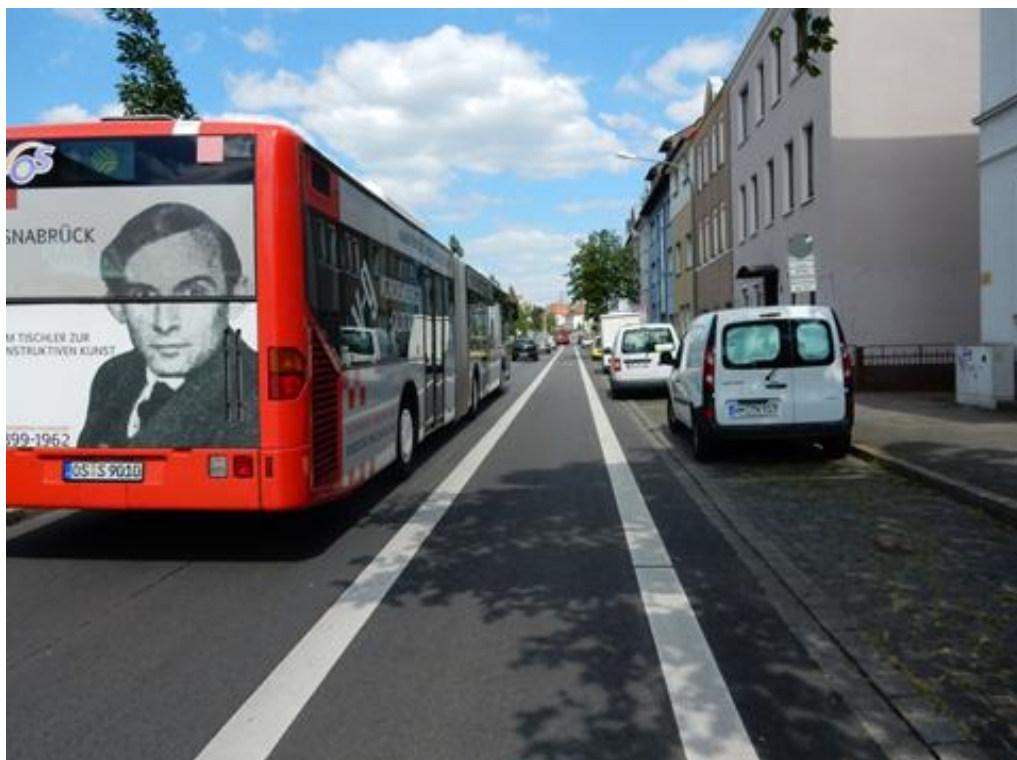
Abb. 18 2,00 m breite Radfahrstreifen in der Bremer Straße in Osnabrück
