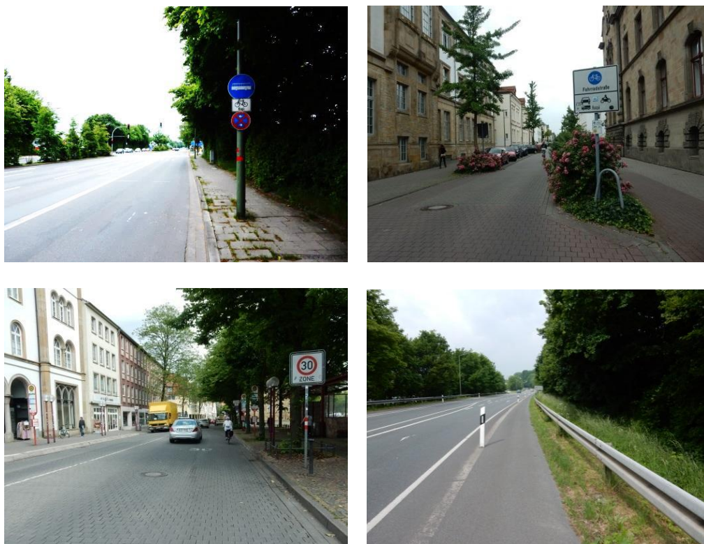
Abb. 20 Radverkehrsführungen auf der Fahrbahn
