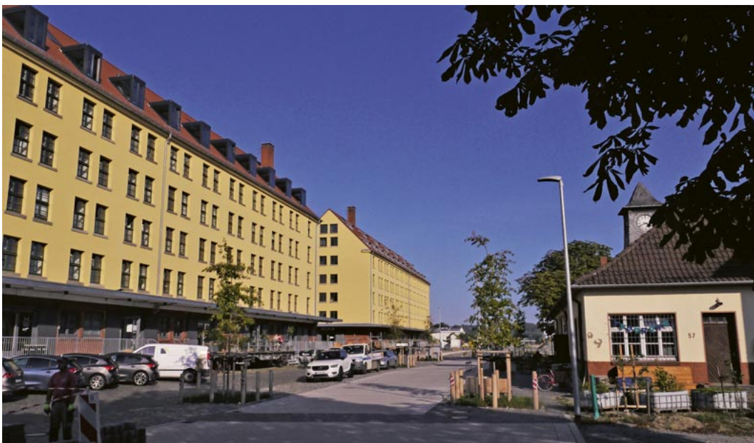
Am Osnabrücker Hafen entsteht seit 2019 ein neues Kreativquartier. Links im Bild Leiser und Lauter Speicher, rechts das Kulturzentrum K.A.F.F. – Kultur am fantastischen Freihafen.
