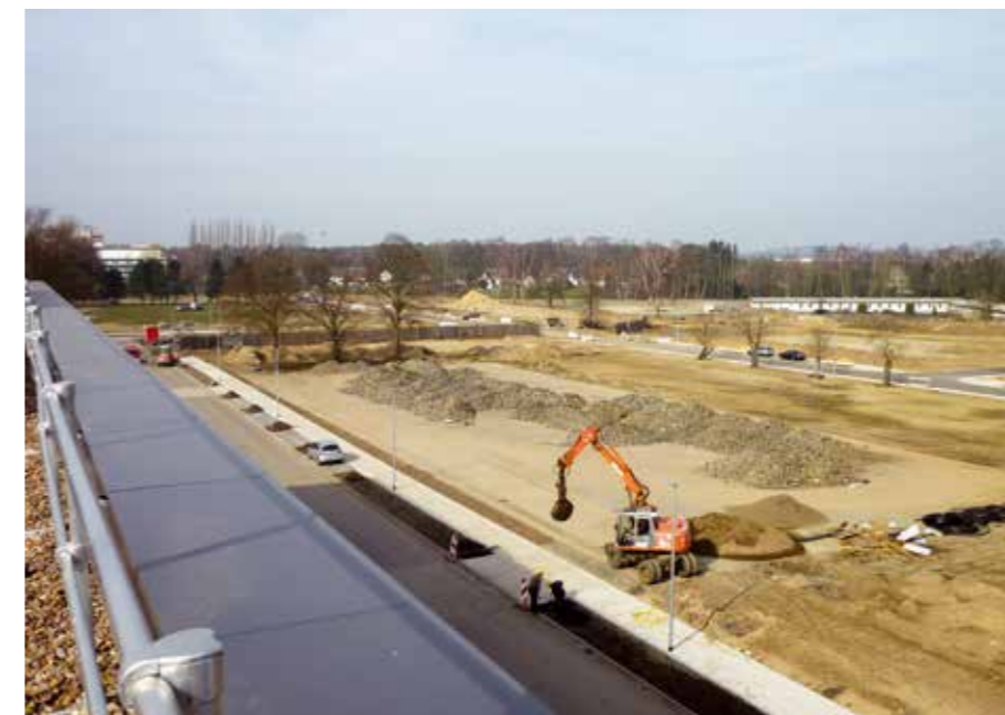
Blick auf das freigeräumte Kasernenareal
