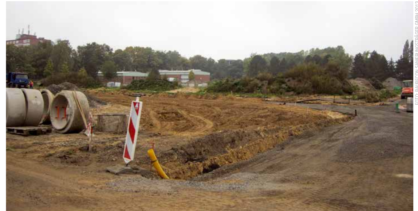
Abbruch und Freilegung
