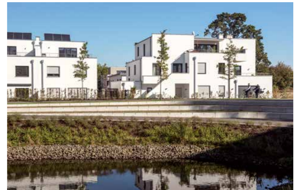
Regenrückhaltebecken mit Wohnpark FAMILIÄR
