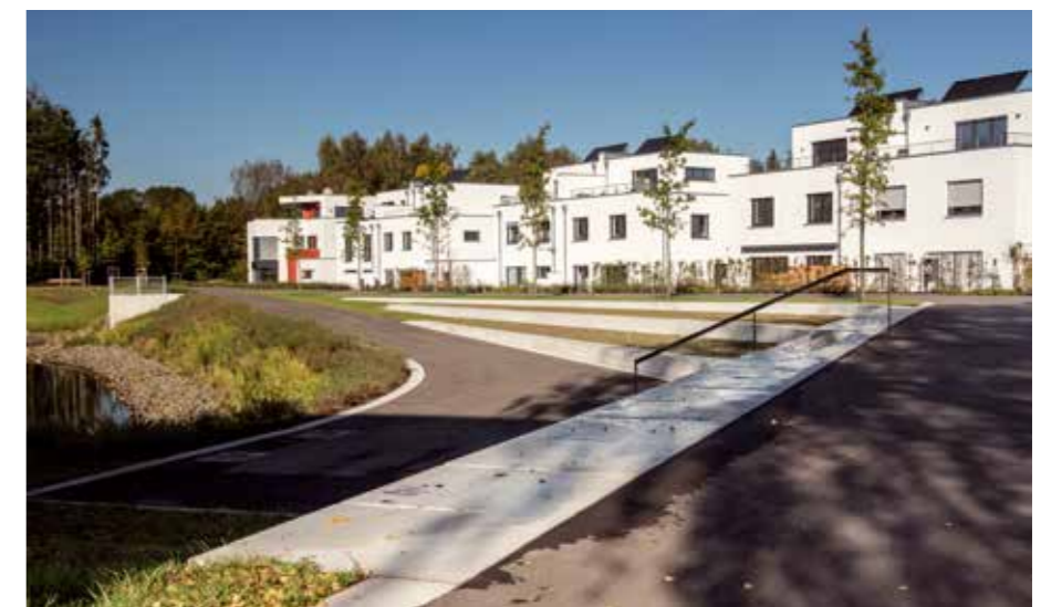
Stufenanlage am Regenrückhaltebecken mit Wohnpark FAMILIÄR
