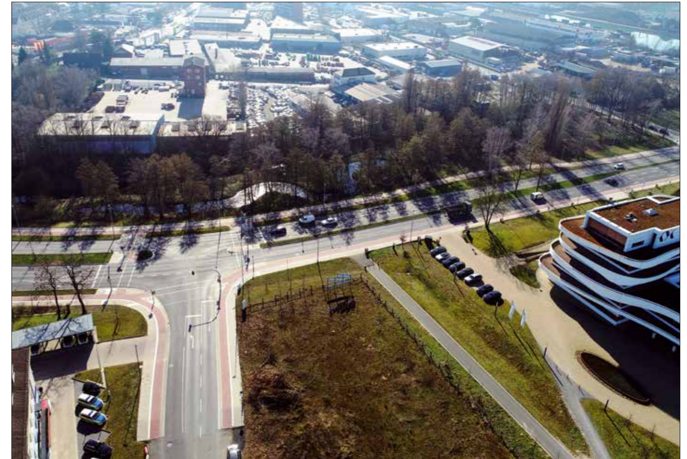
Römereschstraße mit Einmündung Winkelhausenstraße
