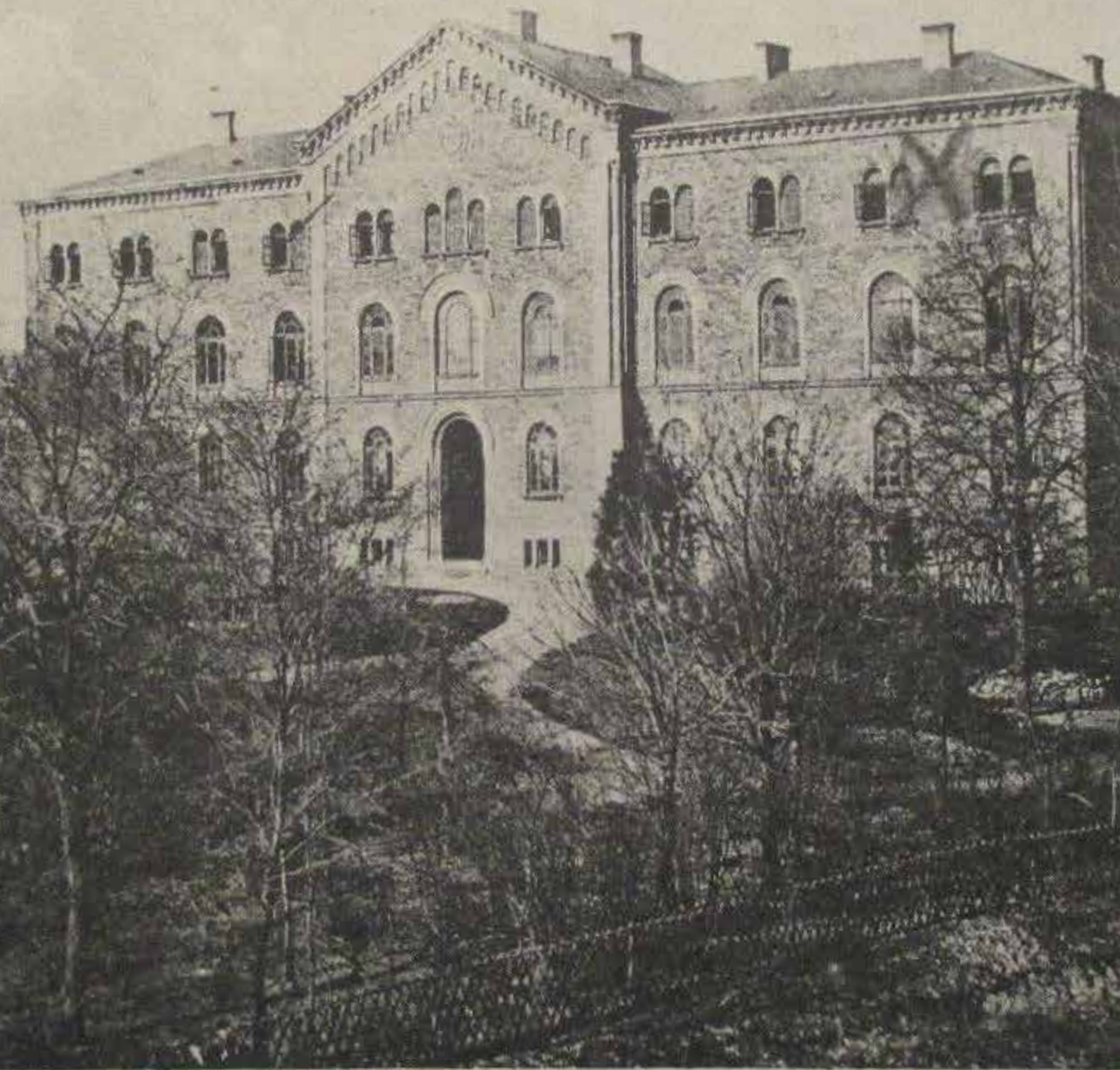
OSNABRÜCK — Städt. Krankenhaus
