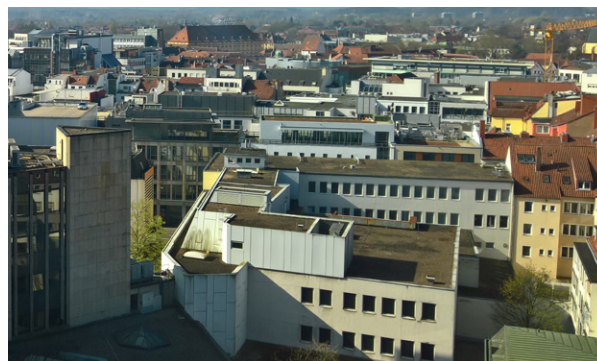
Bitumengedeckte Flachdächer der Innenstadt
